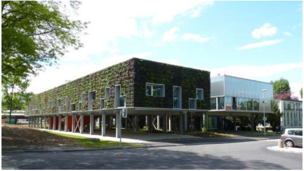
© Photo : Sébastien Muré – Architectes : Sébastien Muré, Cabinet Michel Spitz Architecture, 2014.
